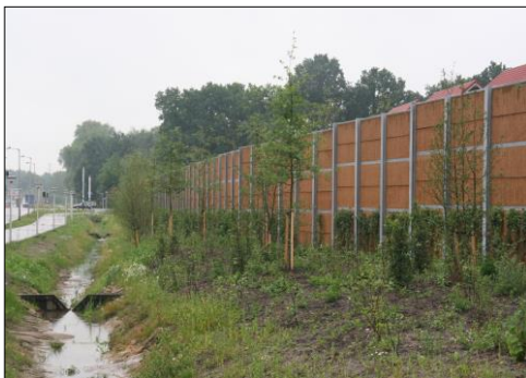
Kokowall geluidsscherm te Enschede, l=200m 5m hoogte.
