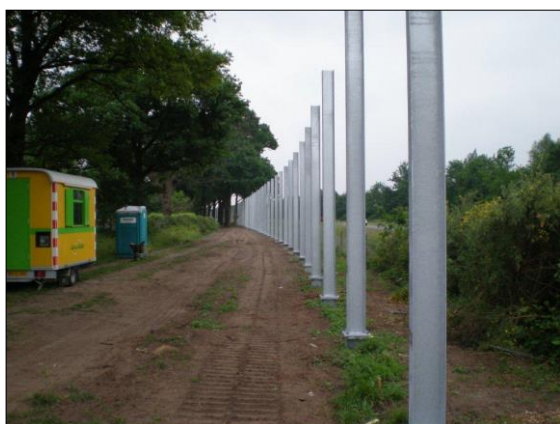
Montage en stellen bovenstijlen
