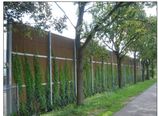
Kokowall geluidsscherm te Vianen, l=200m 3-6m hoogte
