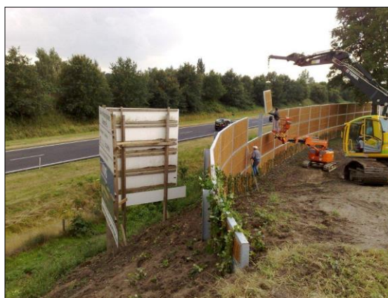
Inhangen en afmonteren panelen
